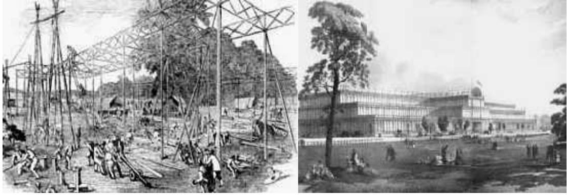
الشكل (٧-٢) صورة في اثناء تشييد القصر البلوري (Curtis, 1996, P.37)
